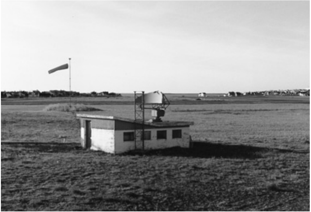
Ratsjánhús og loftnet á Reykjavíkurlugvelli.
